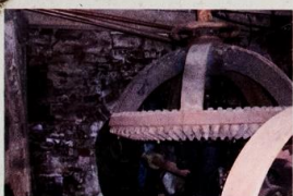
Turbine mit Kegelfrad im Erdgeschoss Foto: P. Petersen
