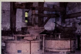
Mahlgänge im 1. Obergeschoss Foto: P. Petersen
